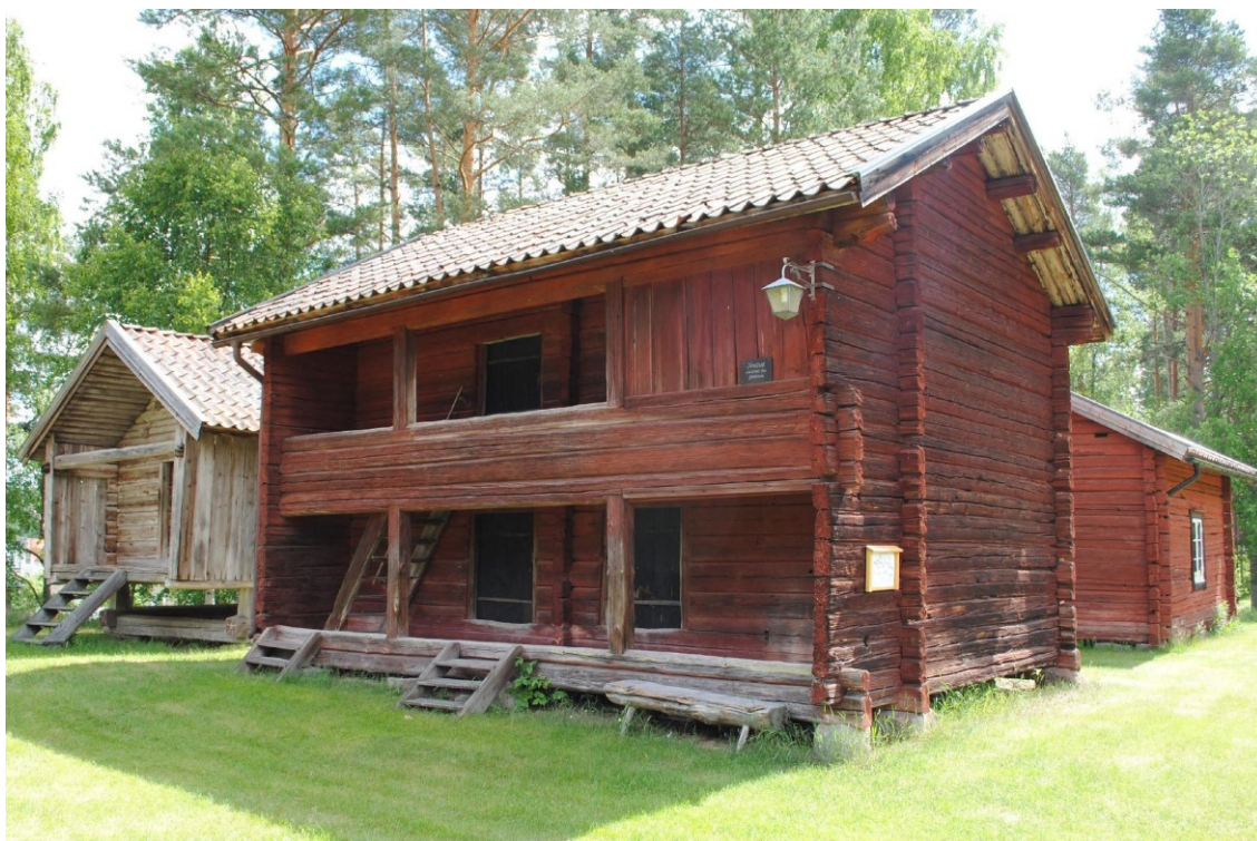
156. Bilden visar Grangärde loftbod, en byggnadstyp som visar på timmertraditionen i Dalarna. I Dalarna finns flera loftbodrar som daterar sig till medeltiden. Foto: Taxelson CCO, via Wikimedia Commons
